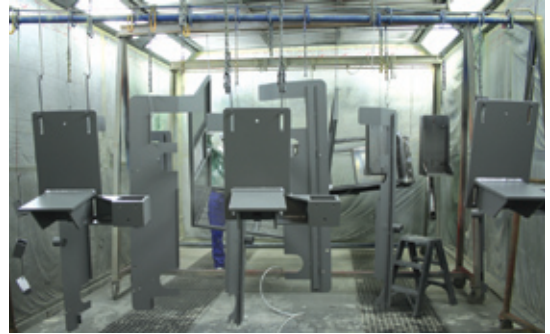
7 - Interno della cabina di verniciatura.
