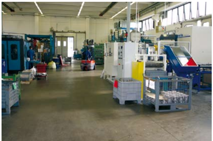
4 - Il reparto che ospita il nuovo impianto di lavaggio (visibile in prospettiva sulla destra).
