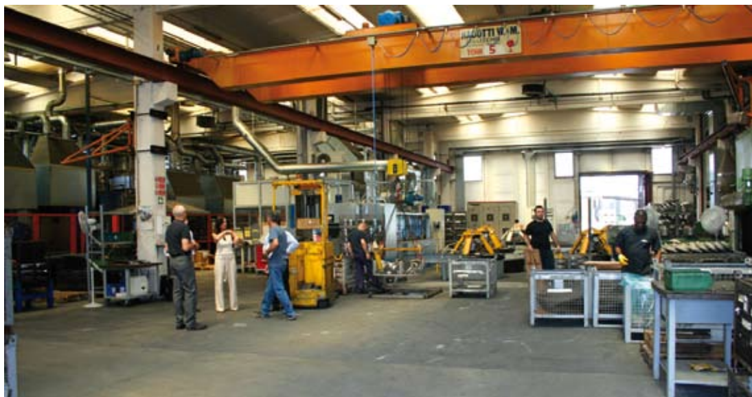
3 - Il reparto dove è installato il nuovo impianto di lavaggio industriale che serve tutte le aziende del gruppo Brevini.
