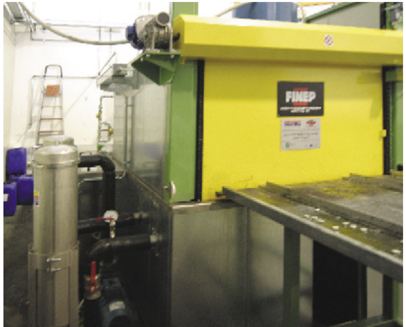
10 - Le altre due colonne filtranti, sul lato opposto.
