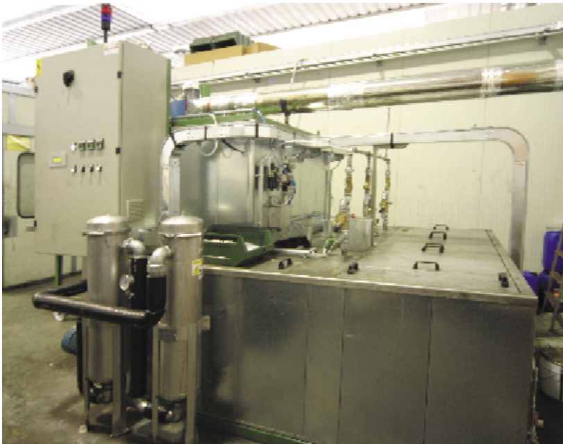
9 - Due colonne filtranti, su un lato dell'impianto.
