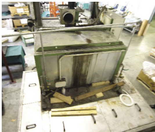
5 - Il vecchio impianto di lavaggio visto dall'alto, dismesso nell'agosto 2006.
