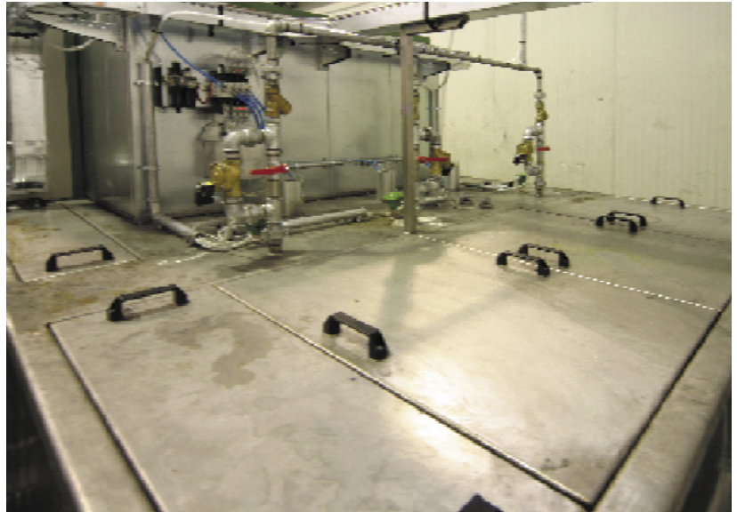
7 - Le vasche del nuovo impianto.
